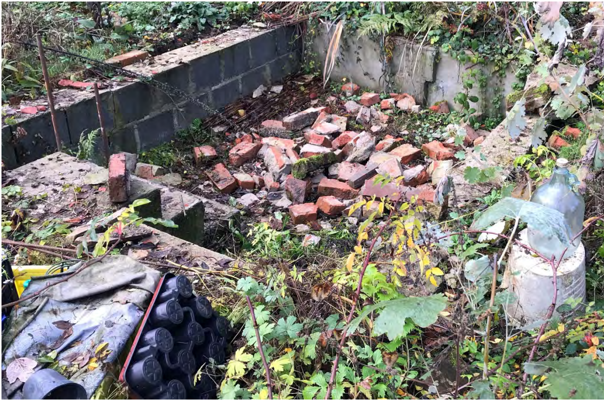
Bild 11, gemauertes Fundament Gewächshaus und Müll (mittlerweile entfernt) Flurstück 75/2, unautorisiert genutzt durch die ehem. Pächter des Flurstücks 73:
